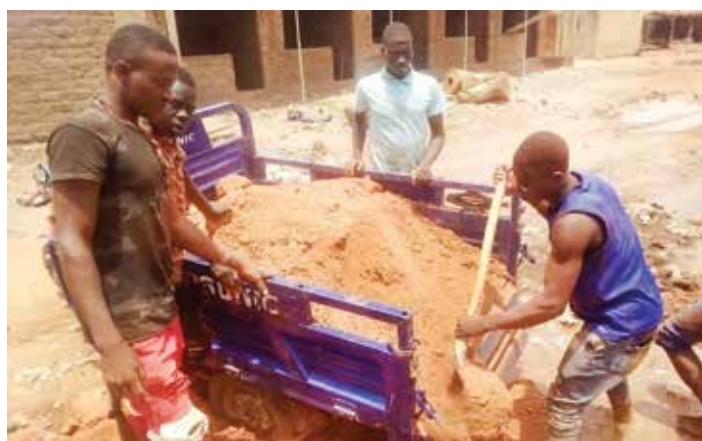
Les jeunes de la commune de Gossima réhabilitant la route d'accès au marché
