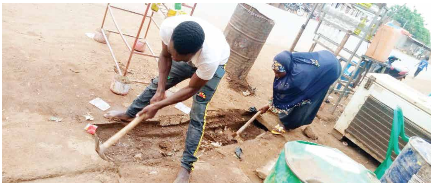
Le CCVC de la commune de Mogtéo entrain de curer les caniveaux des artères de la commune
